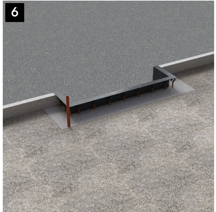
6 Portare a livello con inerte. / Level with aggregate.
